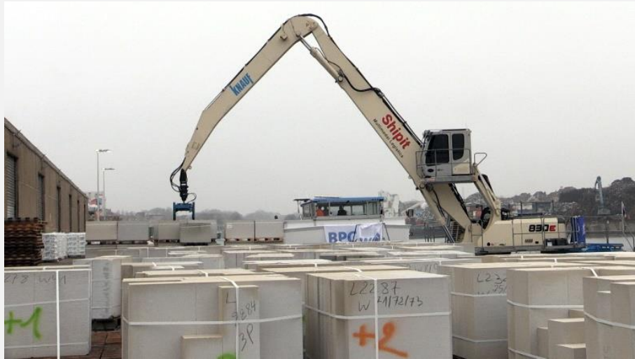
Blocs de plâtre stockés au BCCC dans le cadre du chantier Park West (BPC)
